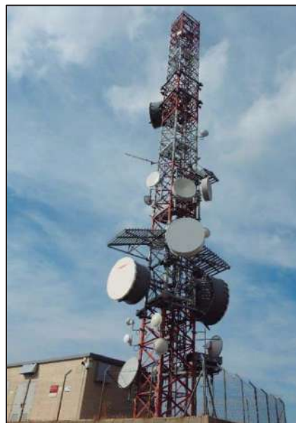
Figura 5.4 Torre 4 del Repetidor de Majalinos.
